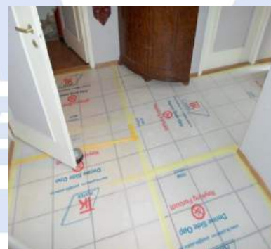
Beskyttelse av fliselagt gulv
