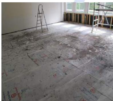
Beskyttelse av gulv ved rehabilitering
