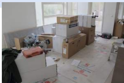
Beskyttelse av ny parkett under bygging av nytt hus
