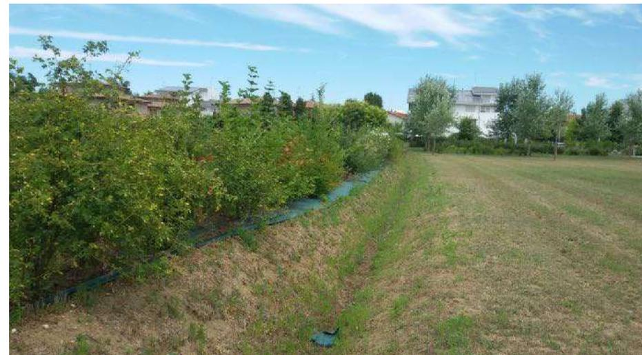
Le pendenze delle superfici pavimentate sono dirette verso le parti a verde, e quindi a permeabilità profonda, senza alcuna interferenza (nemmeno muretti di confine); in questo modo si convoglia nelle superfici a verde, a permeabilità profonda, l'acqua piovana di quasi tutte le nuove superfici pavimentate.
